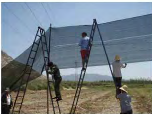
怀来县示范林防风网架设作业
