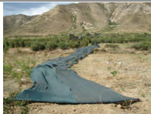
図 7-3-2 柱が弱かったためネットが倒れる
