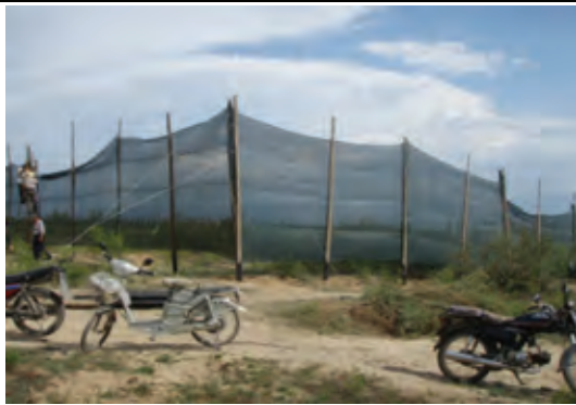
図 7-3-3 柱を補強し、間隔を縮めて再設置
