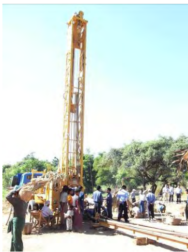
削井状況（Igyi 村） 都市飲料水開発計画（無償、1986）にて調達した掘削機のトラック上部に、TOP300 型掘削コンポーネントを設置
