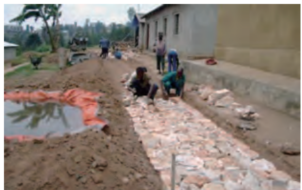
バリアフリー化改修工事(ニャンザ技能研修センター)
