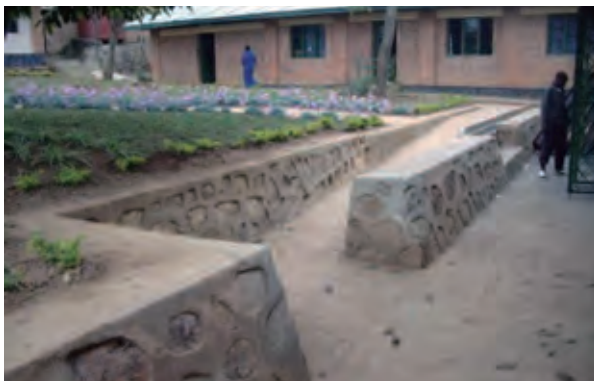
バリアフリー化されたキバリ技能研修センターの施設
