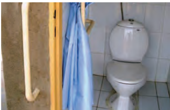
バリアフリー化されたガコ有機農法訓練センターのトイレ
