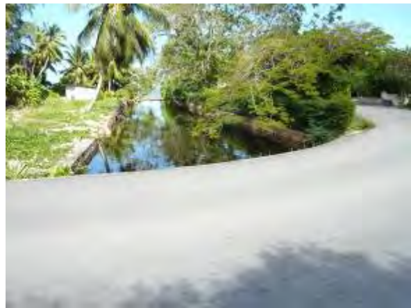
教会付近の排水路、道路及び橋
