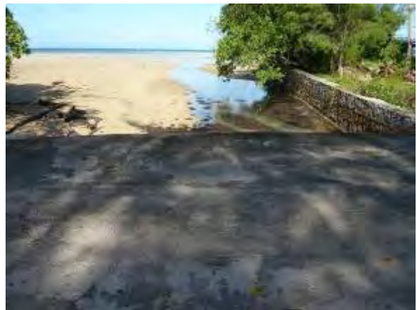
旧橋スラブから下流側の流路（河口閉塞は無い）
