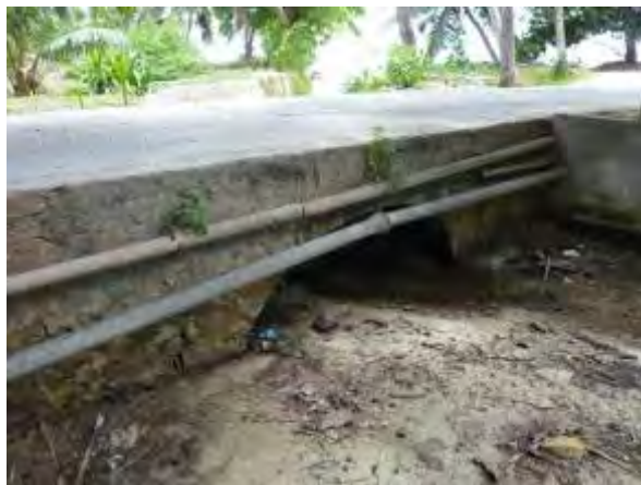
河口にかかる橋（上流側より。左岸側に堆砂あり）
