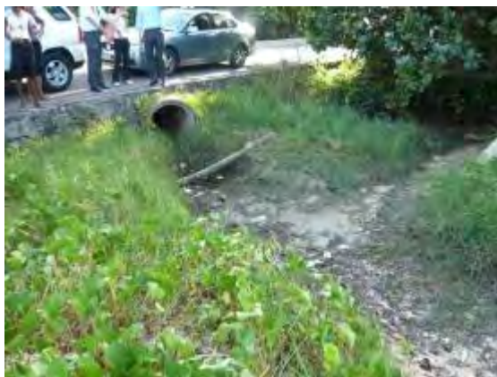
海岸道路の横断排水溝（海側より。前述の湿地の排水先）
