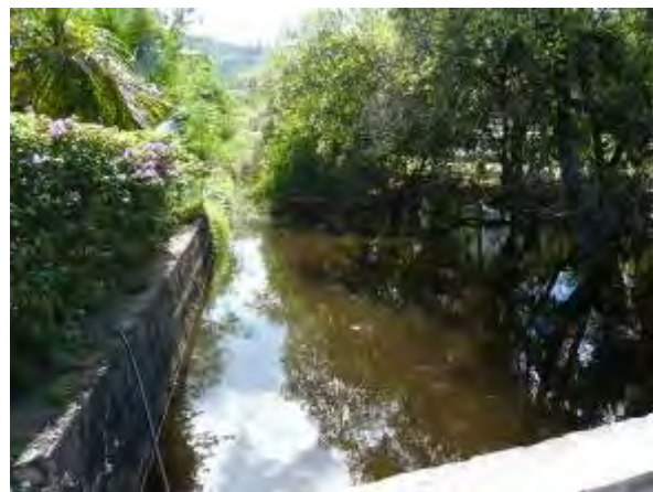
橋上流側の排水路
