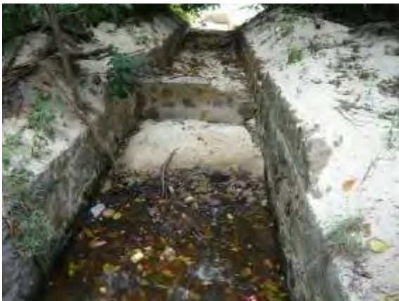
海側の排水路 (中央・防潮壁? 砂止め?)
