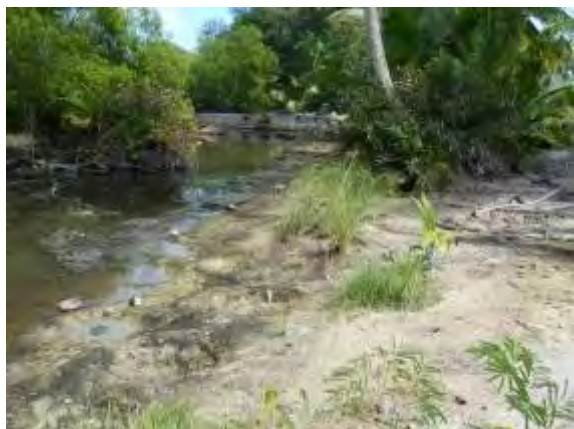
防潮堰遠景 (先の農場の塩害防止のため設置された)
