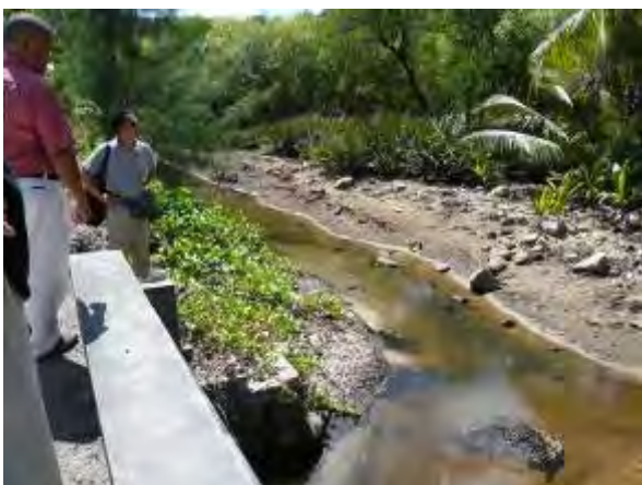
道路沿いの湿地から流れる川と橋 （ここがボトルネックとなり溢水）
