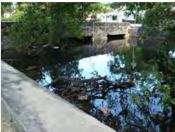
上左に同じ：橋の下のカルバート（開口部が狭い）
