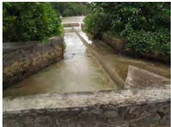
写真 16 マヘ島 Anse Boileau 付近の河口施設。砂の流入を防止する工夫をしている。
