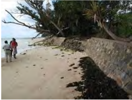
写真1 マヘ島 Aue Cap 海岸の浸食、80年代に練石積護岸が施工されている。
