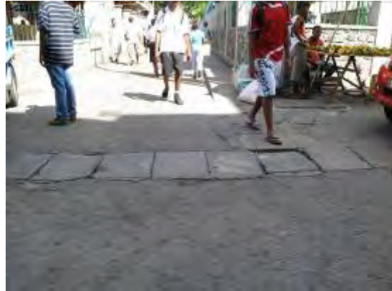
写真 12 ビクトリア市街地の道路内に埋め込まれた排水路。排水路流入口の状況は左上写真。
