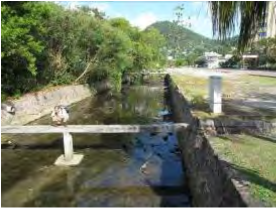
写真 9 ビクトリア市の沿岸埋立地区。十分な広さの排水路が整備されている。
