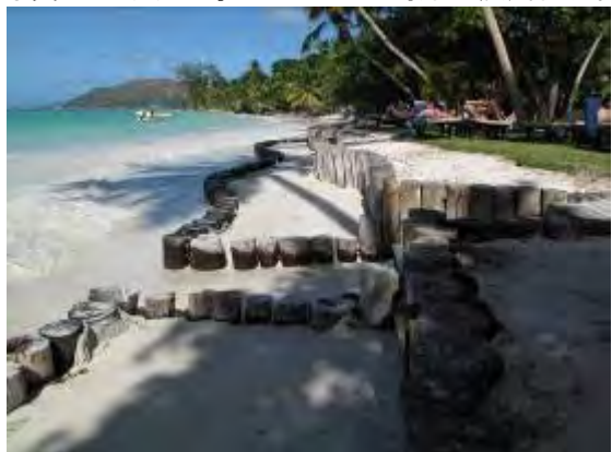
写真8 プラン島 AnseVolveur 海岸の Paradise Sun Hotel が施工した Wooden Piling 護岸。
