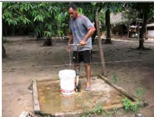
写-10 手押しポンプ、深度 31m —同左
