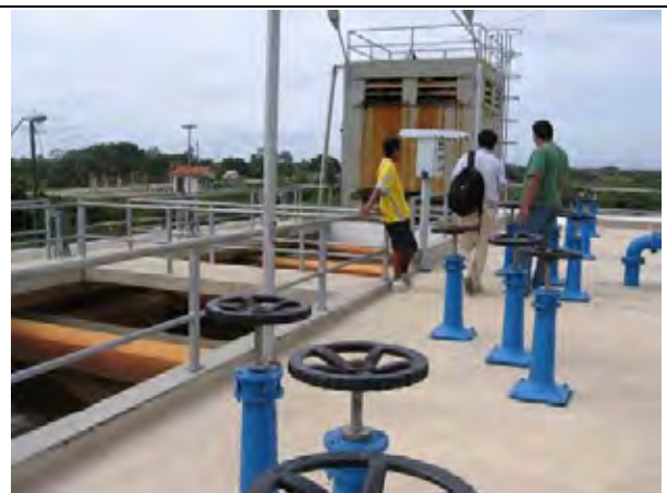
写-6 Trinidad 浄水場 -水組合 COATRI が運営
