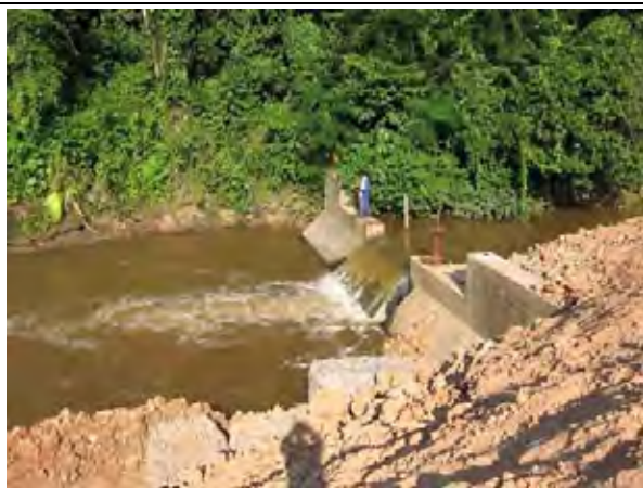
写-27 浄水場の取水工 —Bahia 川
