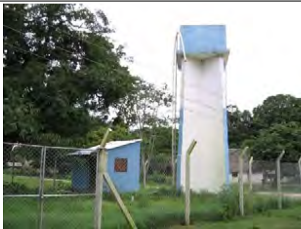
写-13 コンクリート高架タンクの例 ー現在は故障で稼働していない
