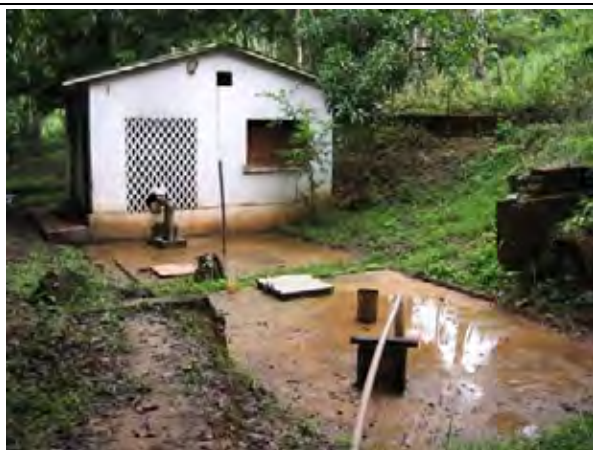
写-25 Villa Busch の貯水槽と送水用ポンプ小屋
