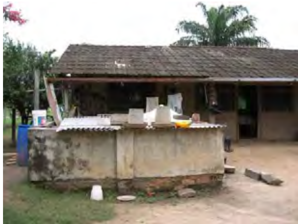
写-15 区長宅の天水溜め ーSachojere ー屋根の水を集める、約3トン
