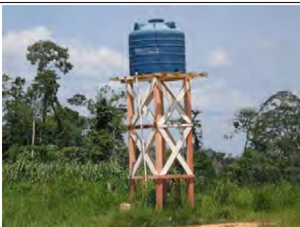
写-33 樹脂の高架タンクの例 ーNueba Triumfo ー学校専用を使用
