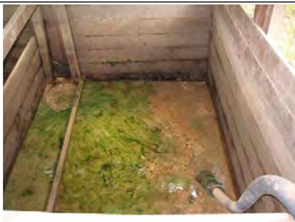
写-29 Puerto Rico 簡易水道の水源 —小川の浸透水を取水、水質は良好
