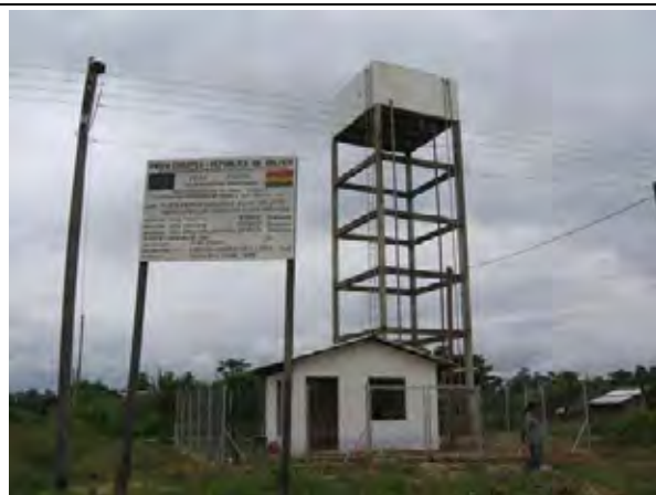
写-30 Puerto Rico の新規深井戸と高架タンク —PRAS PANDO によるもので、写-28 の簡易水道と併用の予定(2007 竣工)
