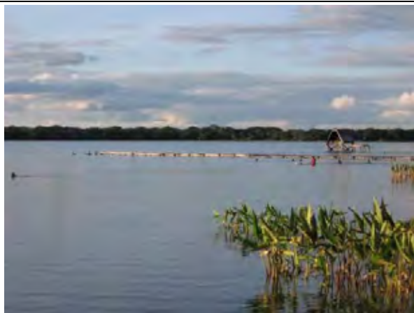
写-17 浄水場の水源 Lagna Isirere ー2台のポンプで取水
