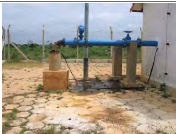
写-8 浄水場に地下水を供給する深井戸 A-5 : 深度 108m、口径 \Phi 10'' 、 Q=27\text{L/s}
