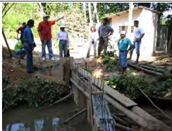
写-32 Mukuden、谷底の小川水源とポンプ小屋 ー小川をミニダムでせき止めている
