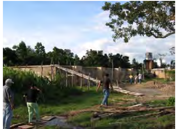
写-16 San Ignacio de Moxos の浄水場（工事中） ー8基の沈殿池を有する本格的なもの
