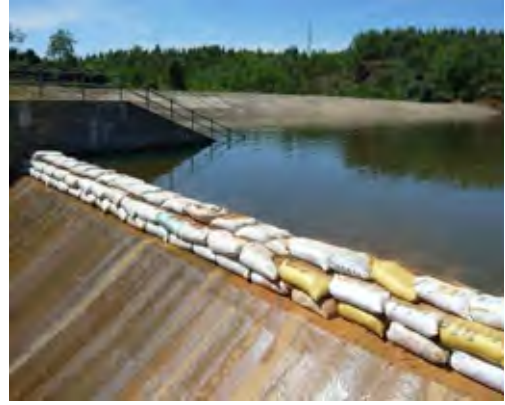
洪水吐堤頂の土嚢(3段積み)
