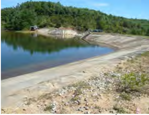
Tra Sow 貯水池 (C.A=1.25 km 2 ) 堤体上流面 (コンクリートフェイシング) 及び洪水吐
