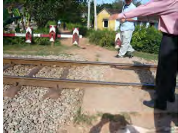
鉄道横断箇所（道側が両側に柵を設けたため、車の通行不可）。
