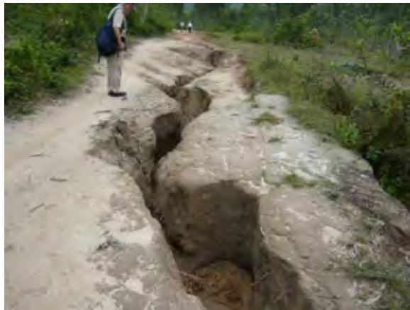
貯水池へのアクセス（路面状況は非常に悪い）
