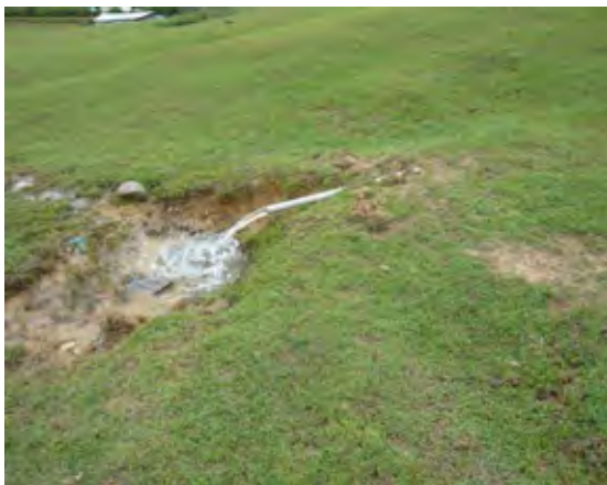
サイフォンによる塩ビ管を使った貯水池からの直接取水（堤体下流面）
