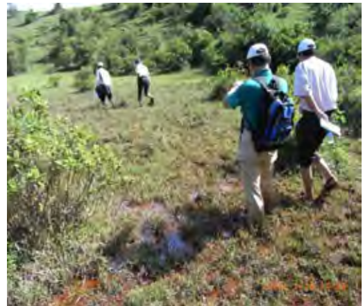
堤体下流法尻部の漏水により湿地状態となっている。
