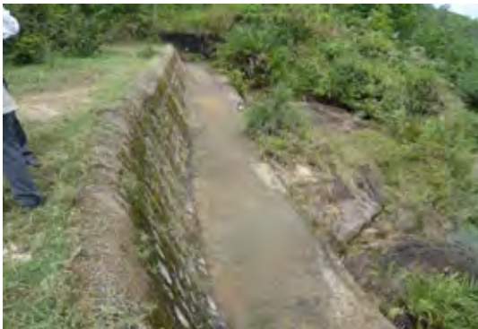
練石積の落差工及び下流流路
