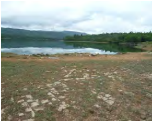
洪水吐流入部(一応、石張りになっている)
