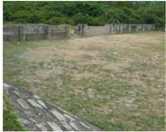
中央部の越流堰及び角落しの設置状況
