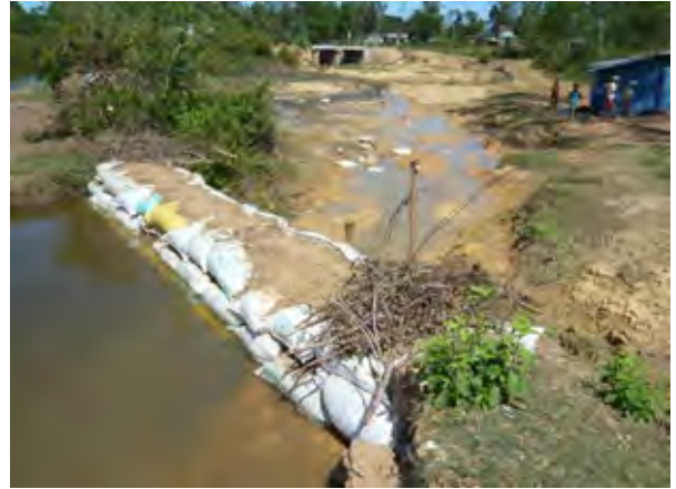
嵩上げ部土嚢部分及び下流のボックスカルバート
