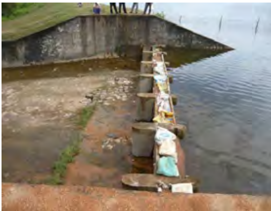
洪水吐角落し設置状況
