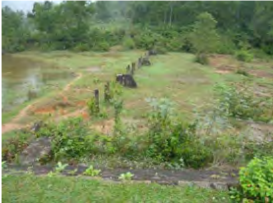
洪水吐流入部（角落し用杵が設置されている）。
