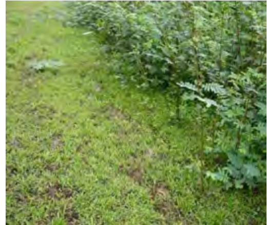
漏水箇所は灌木が生い茂っている。
