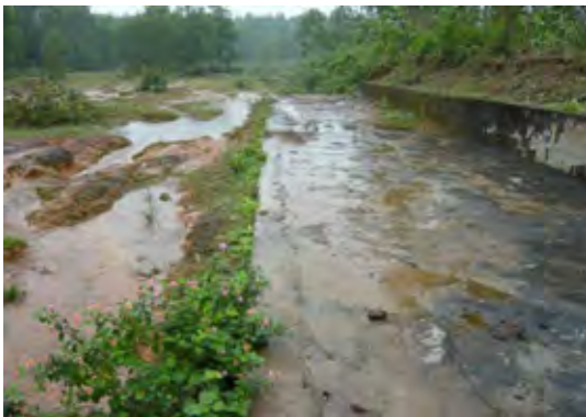
洪水吐流下部（右岸側は堤体のためコンクリートで保護）。
