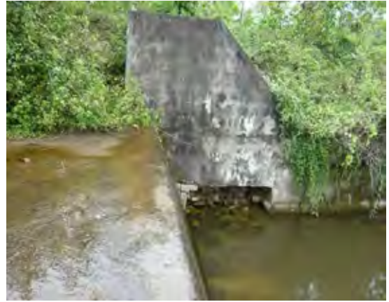
第二落差工左岸側側壁
