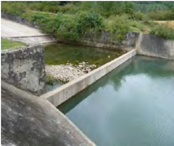
シュート部末端、減勢池、接続水路
