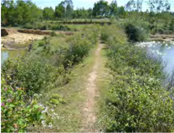
締切堤(右側:貯水池、左側:洪水吐下流)
