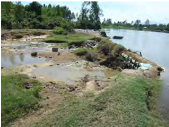
自然地形を利用した洪水吐。手前部分が締切堤。
