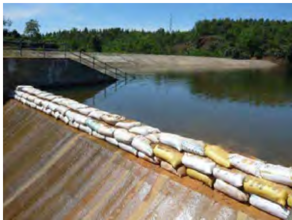
クアンガイ省により修復された土堤。堤体上流面(奥)はコンクリートフェイスングが施されている。手前は農民によって嵩上げされた洪水吐呑口部。
