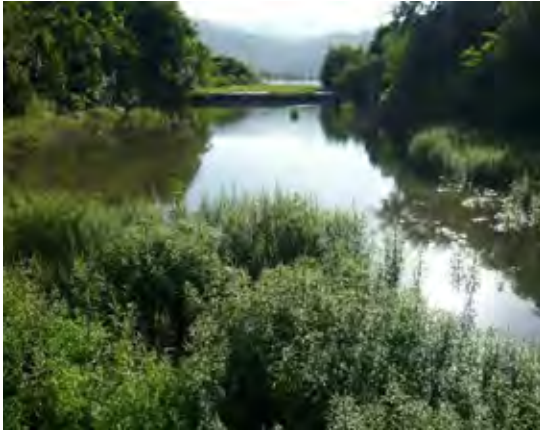
洪水吐流入部及び第一落差工
