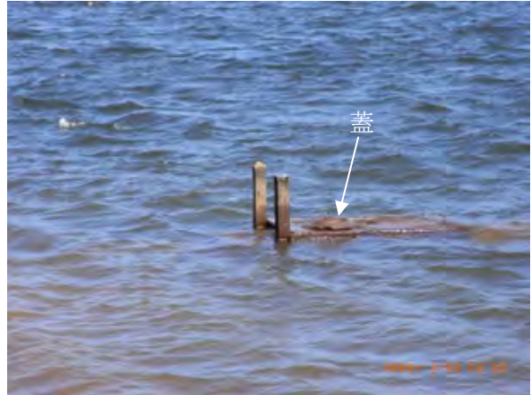
取水工は池の中であり、コンクリートの蓋で開閉を行う。
