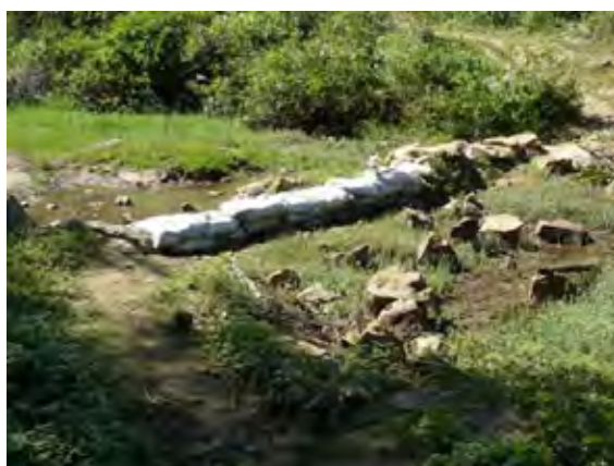
洪水吐流入部の岩、土嚢による嵩上げ。
