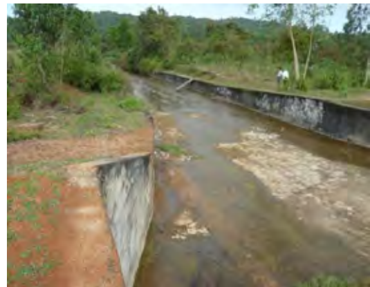
洪水吐シュート部
