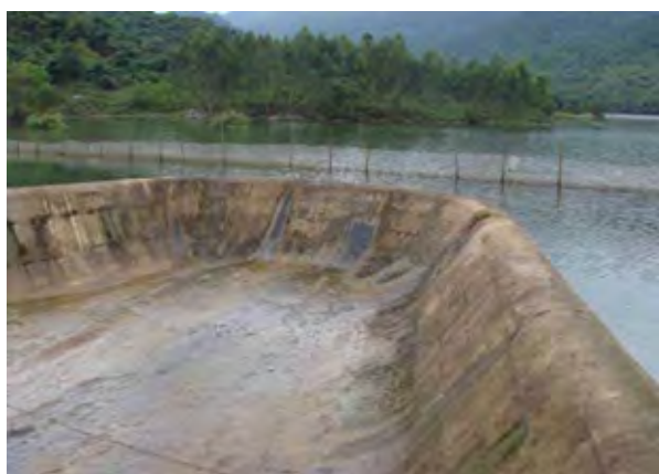
ADBの支援により修復された Hoc Sam 貯水池の洪水吐。規模は他の貯水池と比較してかなり大きい。
