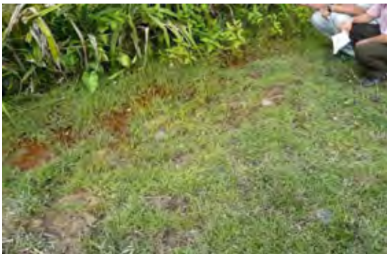
下流側堤体法尻の漏水箇所。基本的に灌木の生い茂っている箇所に漏水有り。
