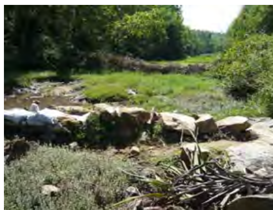
嵩上げ箇所より下流側を見る（流路は水田に利用されている）。
