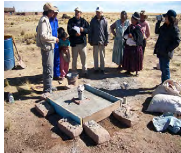
井戸工事施工・管理の説明（オルロ県クラワラ・デ・カランガス市）
