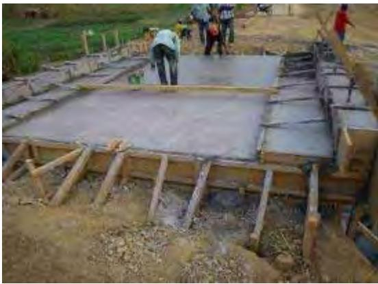
Injection du béton au pont N° 3
