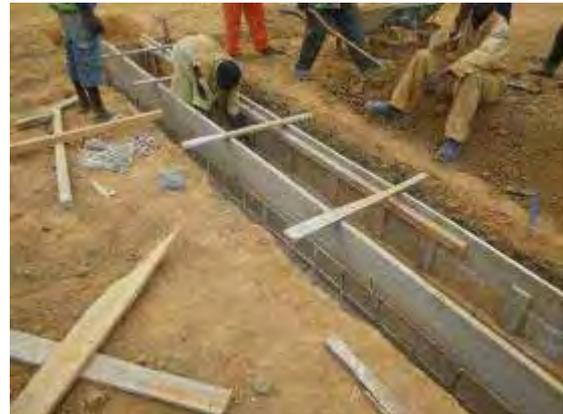
Installation des tuyaux de drainages transversaux à Kisiama
