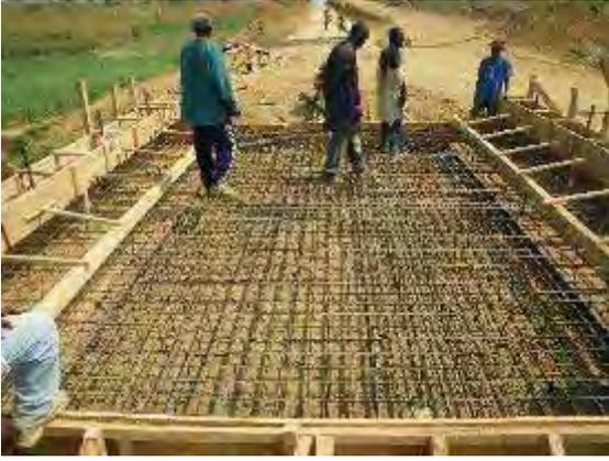
Construction du pont N° 3 (béton armé)
