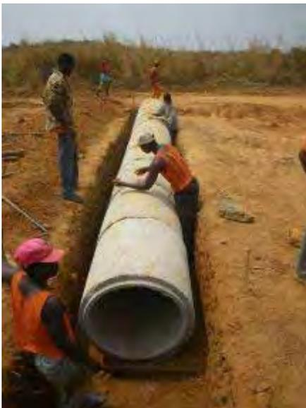
Installation des tuyaux de drainages transversaux (2)
