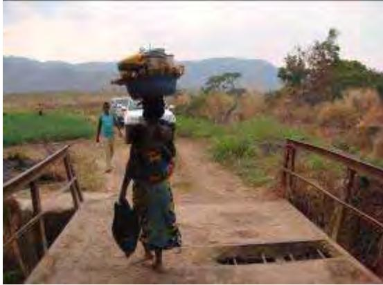
Le pont en danger de traverser par le véhicule à cause des trous.
