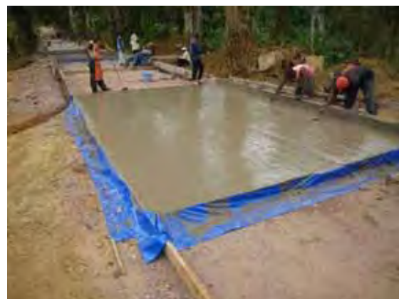
コンクリートの打設・仕上げ
