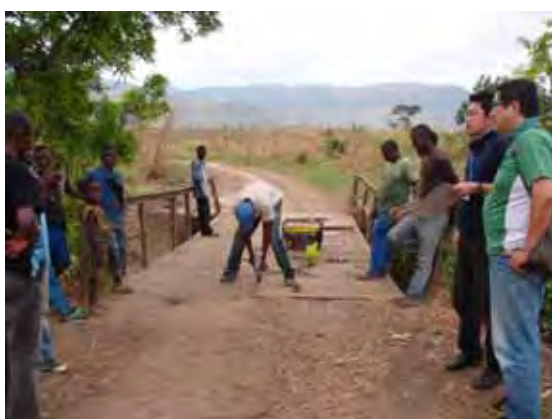
フィーダー道路改修の一環で、橋が改修された
