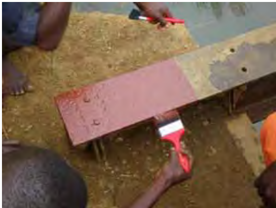
既設鋼材の塗装（2号橋梁）
