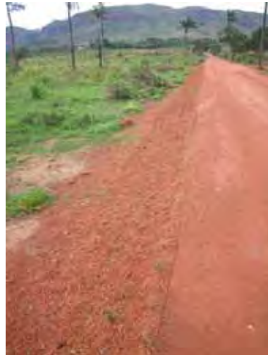
盛土法面植生
