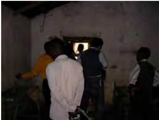
改修前の Kinanga のヘルスセンター内部
