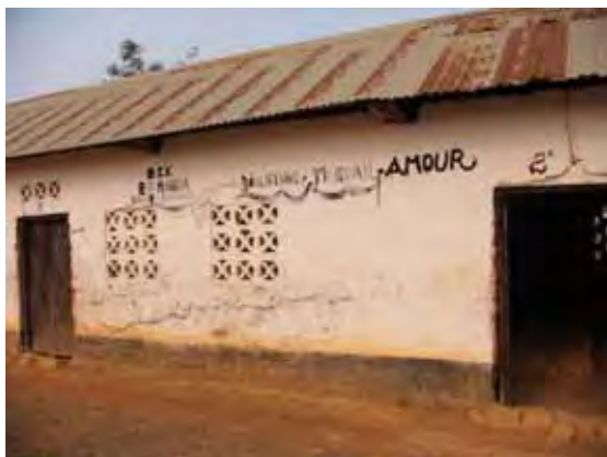
改修される前の学校の外観
