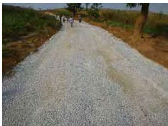
路盤 (碎石使用) の設置
