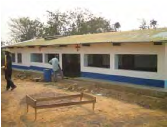
改修された Malanga Cité のヘルスセンター
