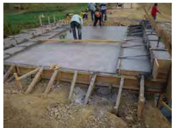
コンクリート打設（3号橋梁）
