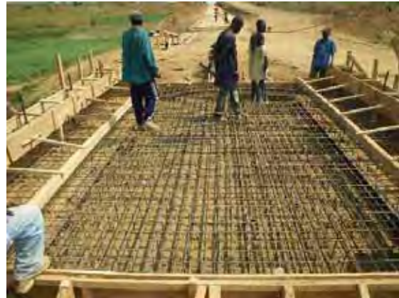
鉄筋組み立て（3号橋梁）
