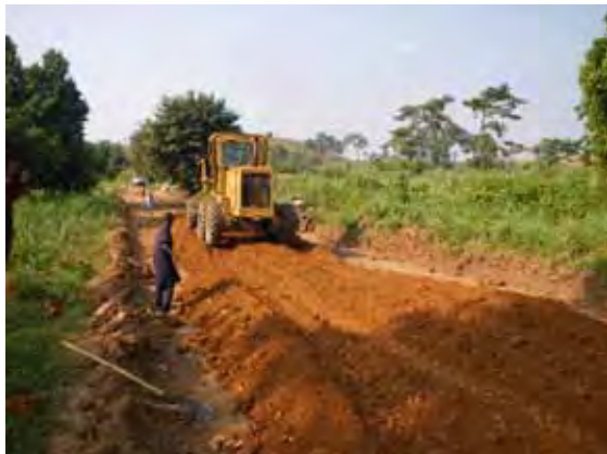
ラテライトの撒き出し
