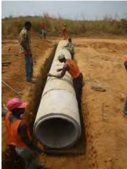
横断工の設置
