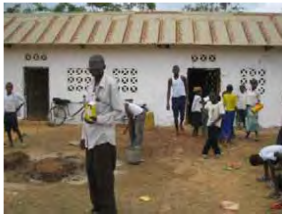
改修後は外観も綺麗になった
