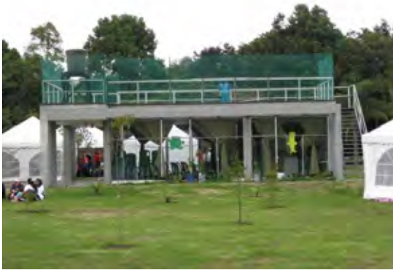
プロジェクトが建設した研修センター
