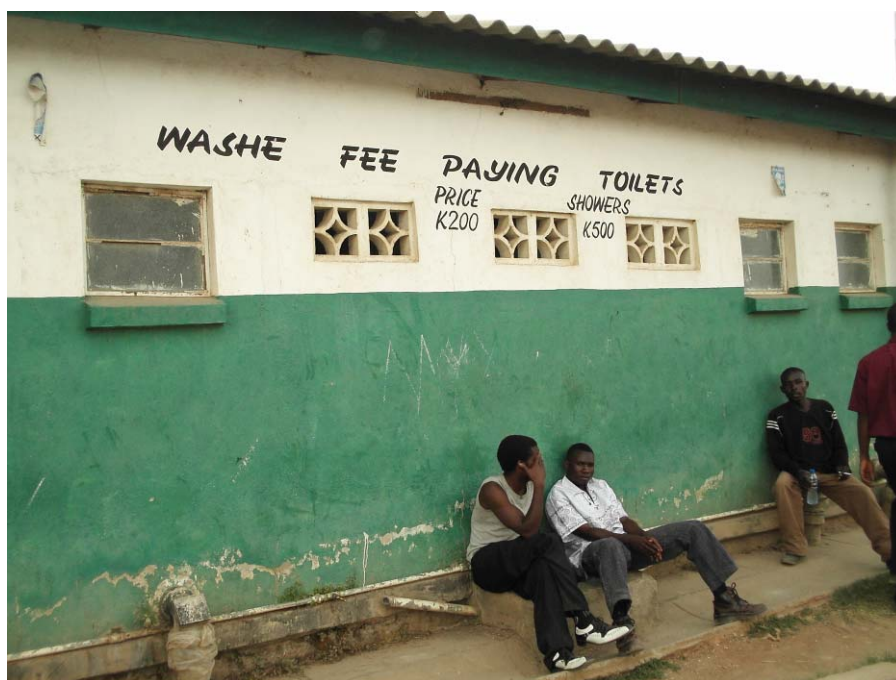
所得創出活動（IGA）のため、水、衛生及び保健教育実施体（WASHE）が設立した有料公衆トイレ（ンドラ郡）
