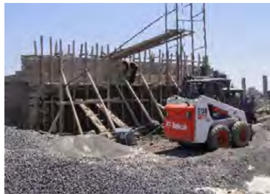
P- 40 建設中の新中継施設
