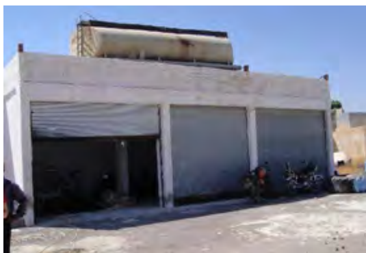
P- 35 ガレージの倉庫
