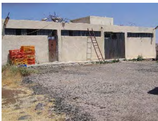
P- 39 ガレージの倉庫
