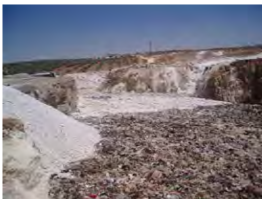
P- 15 ムスビン処分場の既存埋立エリア (奥は白い土砂で覆土がなされている)
