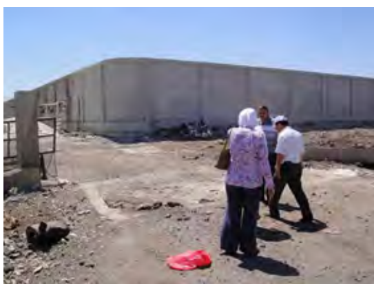
P- 31 既存中継施設
