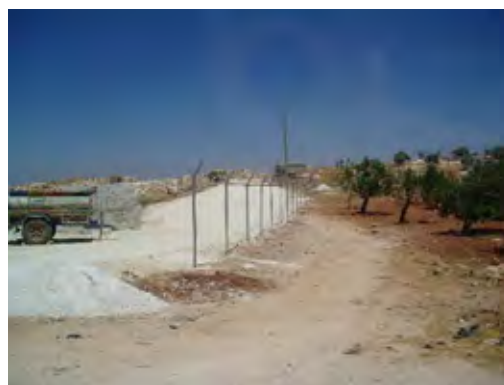
P- 16 ムスビン処分場の境界フェンス (建設中)
