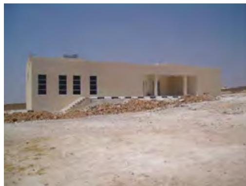
P- 24 改善カスン・アル・ジャバル処分場の管理棟（建設中）
