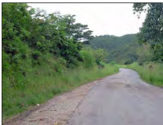
写真 3-2-1 現況切土法面の状況
