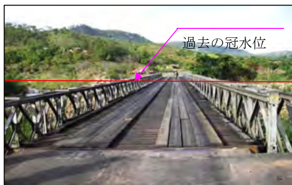
写真 3-2-1 既存ルクル橋の過去の冠水位
