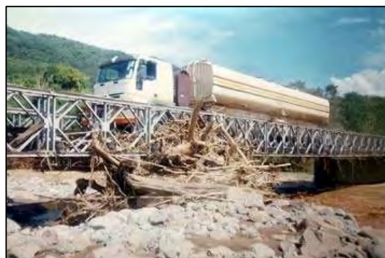
写真 3-2-2 既存ルクル橋の洪水被害
