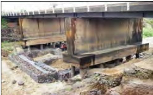
写真 2-2-3 チャモノ橋（3径間単純鋼合成桁）
