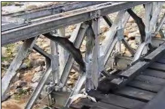
写真-5：狭幅員のため車両の衝突により損傷したトラス部材
