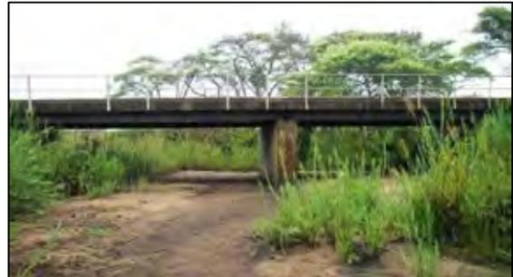
写真 2-2-4 ルコンコメ橋（2径間単純鋼合成桁）
