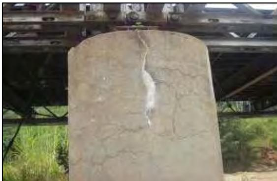
写真-7：ひび割れが著しく、老朽化が進む橋脚
