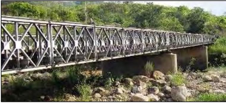
写真-1：築30年が経過し、老朽化が進む架設構造物（ベイリー橋）である既存ルクル橋（側面）
