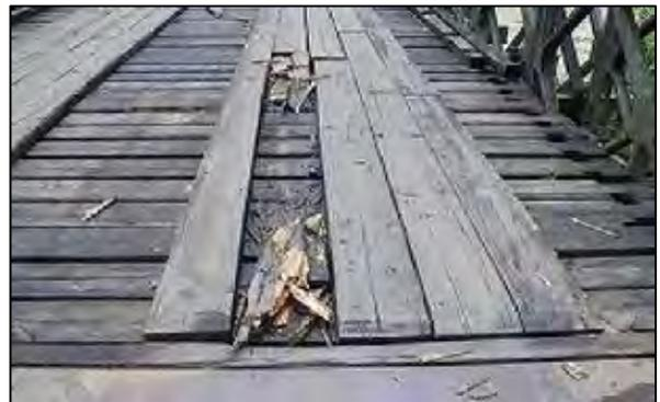
写真-6：重車両の通過により損傷した木製の床版
