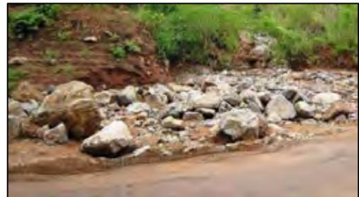
写真 2-2-6 豪雨による斜面崩壊状況
