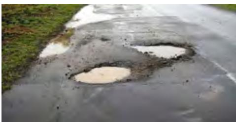
写真 2-2-7 舗装修復後に生じたポットホール
