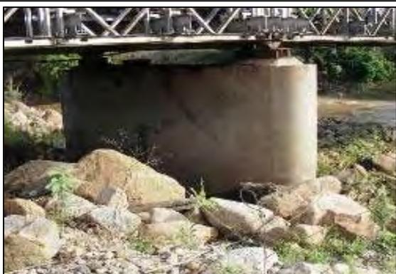
写真-11：洪水時の転石により埋もれた橋脚
