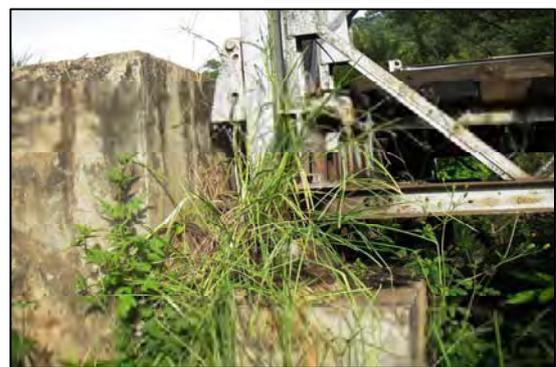
写真-8：腐食が進むトラス部材と老朽化する橋台
