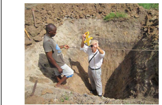
既設上水道管の埋設状況 (埋設管の位置、深さの直接確認)
