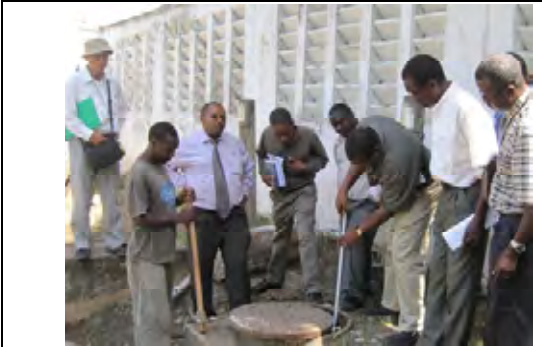
民有地内に位置する 既存上水道管(合同視察状況) (モロッコ交差点より0.3km 付近)
