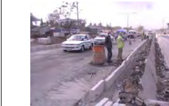
EU 無償による都市幹線道路整備事業 (ネルソンマンデラ道路での縁石敷設状況)
