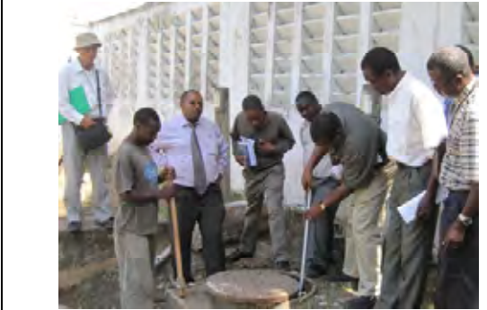
民有地内に位置する 既存上水道管(合同視察状況) (モロッコ交差点より0.3km 付近)
