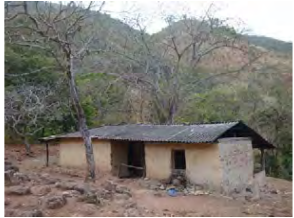
シグアパ川中流右岸の民家
