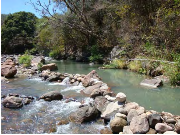
ユカングアレ川上流石積堰
