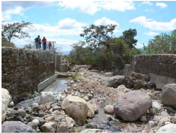
コマヤグア盆地の PROMORCO : 洪水で破壊された蛇籠堰
