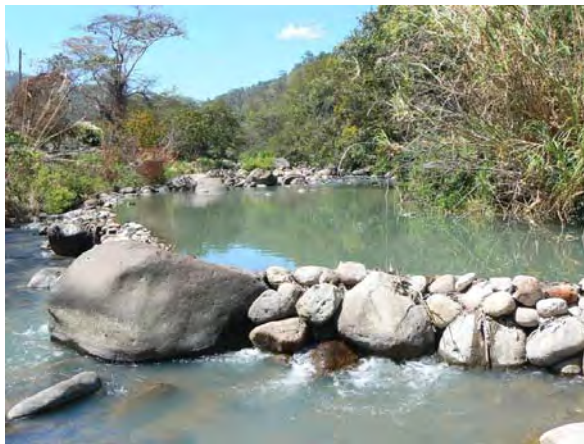
ユカングアレ川石積堰
