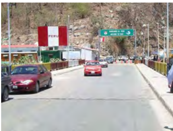
写真-5: エクアドル側橋台付近から見た既設マカラ橋の橋面の現況。
