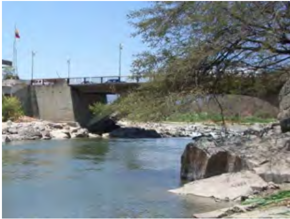
写真-1: 下流側ペルー側から見た既設マカラ橋の現況。
