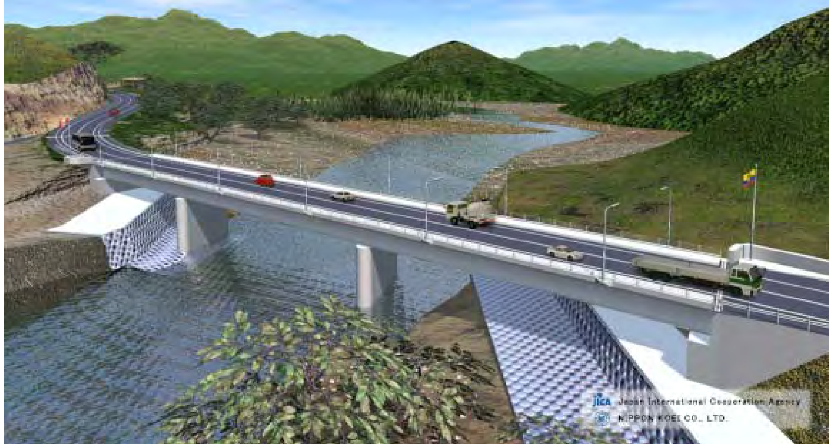
新マカラ国際橋 (PC3 径間 I 桁橋)
