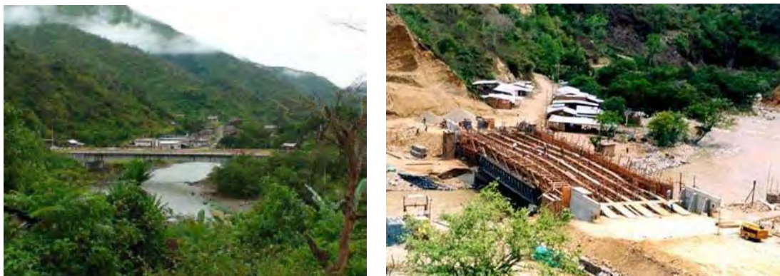
図 2.3.3 バルサ橋現況写真(右写真は建設当時)
