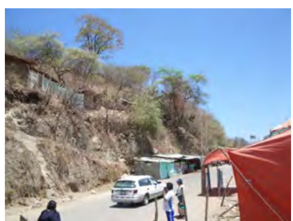
写真-6: ペルー側取付道路計画地の現況。
