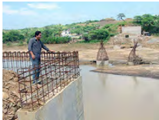
図 2.3.2 エル・アラモール橋現況写真
