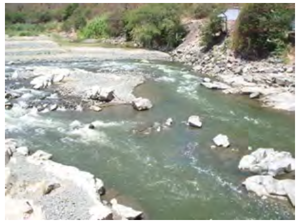
写真-2: 既設マカラ橋流上から見たマカラ川上流域の状況。
