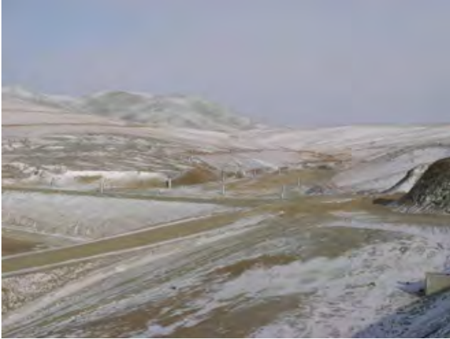
建設中のNEDS(第1次調査時)
