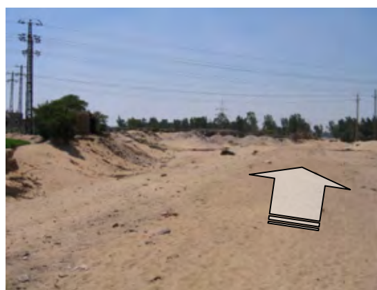
Barakat 排水路からの放流渠建設予定地景観（2）
