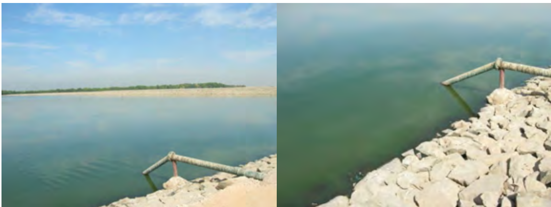
下水処理施設（酸化池・熟成池、プロセス：流入→嫌気性池→通性嫌気性池→熟成池→放流）
