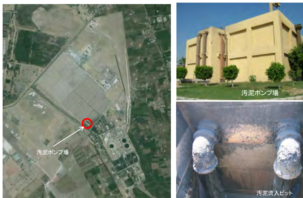
図 4.12 汚泥ポンプ場における臭気測定調査の試料採取点
