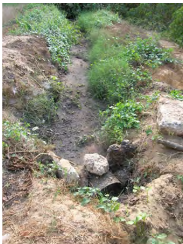
灌漑用水（一次処理水＋生下水）の導水路
