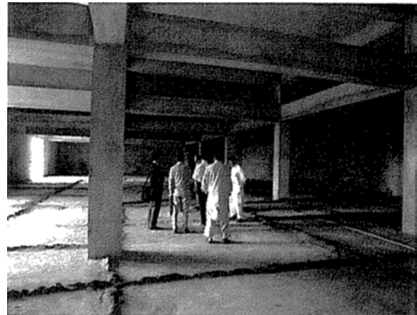
10月15日、新築中のワクチン倉庫の内部。2009年3月ごろ完成予定
