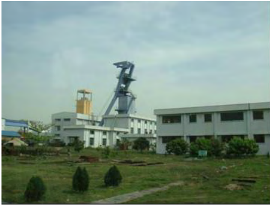
図 3 - 7 材料・人員用立坑と 奥が揚炭用スキップ立坑
