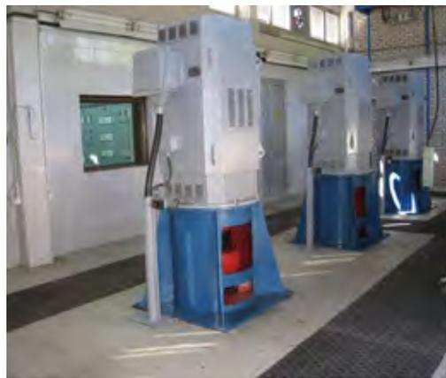
写真3 Mareza2 縦軸ポンプ・モータ部
