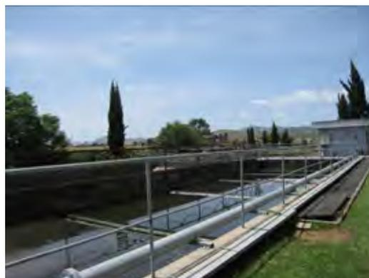
写真5 ポトゴリツァ市下水処理場、最終沈殿池
