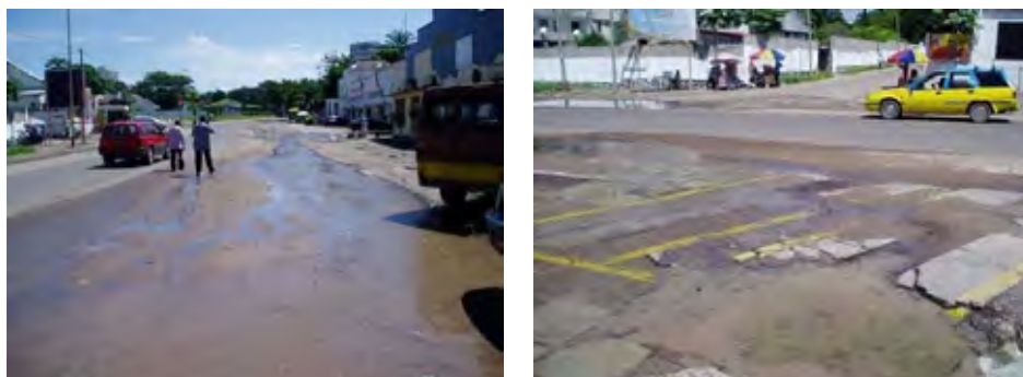
写真-1 ジャスティス通りの漏水の様子
