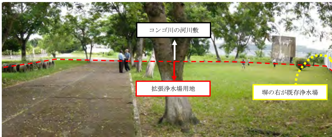
写真-2 拡張浄水場用地全景
