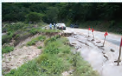
パイロット工事着工前
