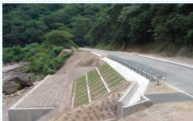
パイロット工事完成
