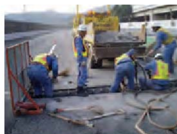
伸縮装置の取替え
