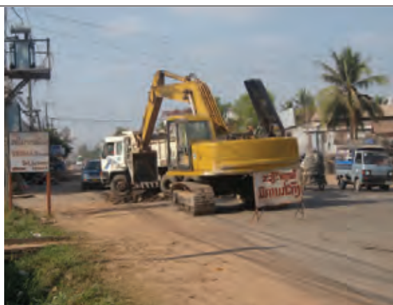
舗装の修繕工状況（舗装の打換え）
