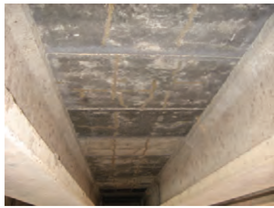
コンクリート床版の縦方向クラックに対するセメントペーストによる修復状況
