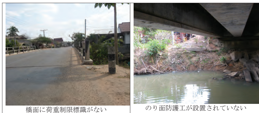
図 3.5-1 北 13 号線 Houay Xon 橋の現況
