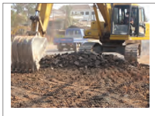
写真 4.4-2 舗装の補修実施状況
