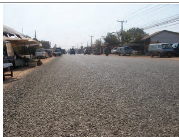
簡易舗装（DBST）による舗装打換え状況
