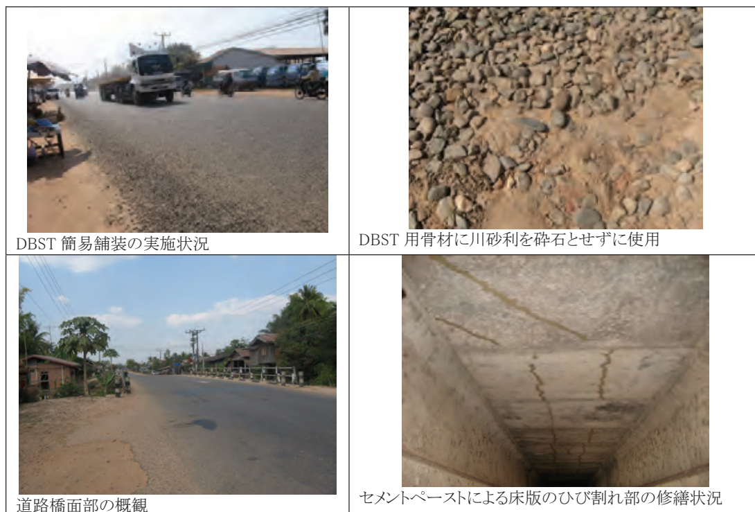
写真 4.4-1 道路・橋梁の修繕状況
