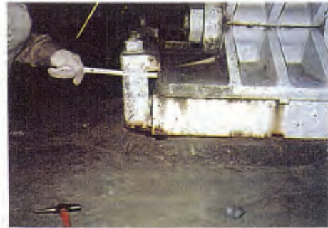
サイドブロックの傾斜損傷例
