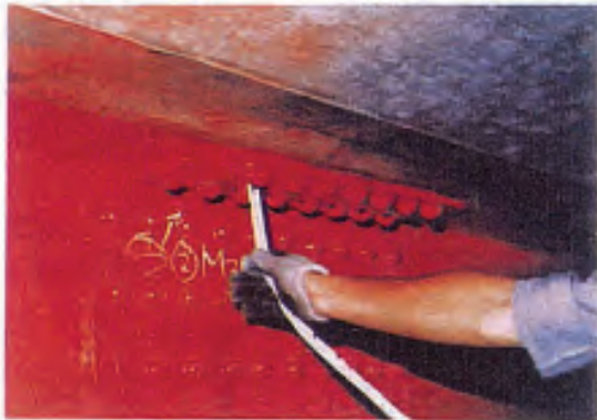
ボルトのゆるみ損傷例
