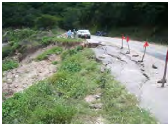
パイロット工事着工前
