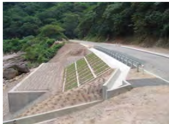
パイロット工事完成
