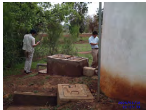
全国地方給水衛生プログラムによるドドマ州 Mpwapwa 県の Level-2 の貯水槽の視察
