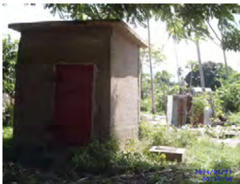
WaterAid 支援による Level-2 施設は、機材仕様が不適当で水委員会で機材を全て撤去した。
