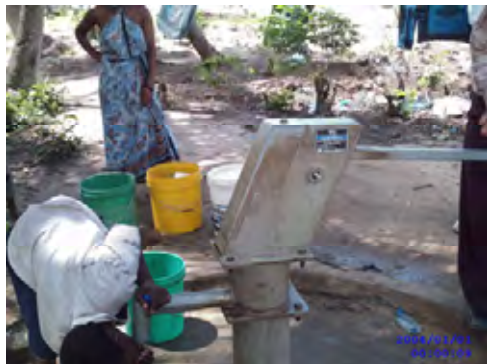
WaterAid の給水施設（Level-1）でハンドポンプはナットが無いままの状態で使用されている。
