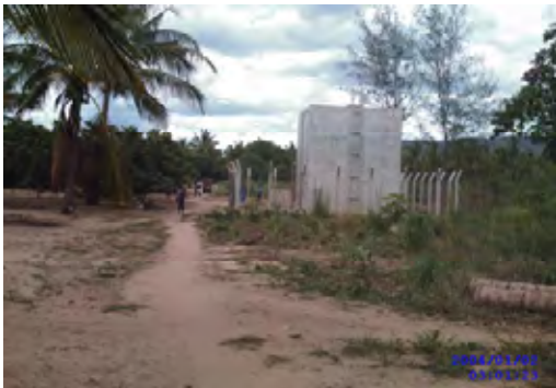
無償実施プロジェクト(Level-2)のパイプスキムにおける貯水槽
