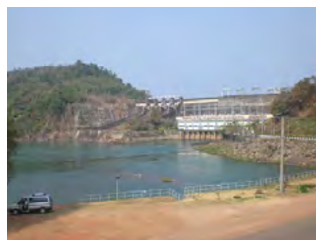
ナムグム第一発電所
