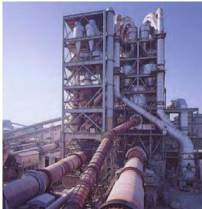
Hình 2.8.5-2 Xi măng lò quay với NSP
