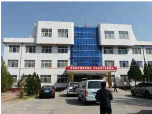
寧夏・樹新国有林場管理棟
