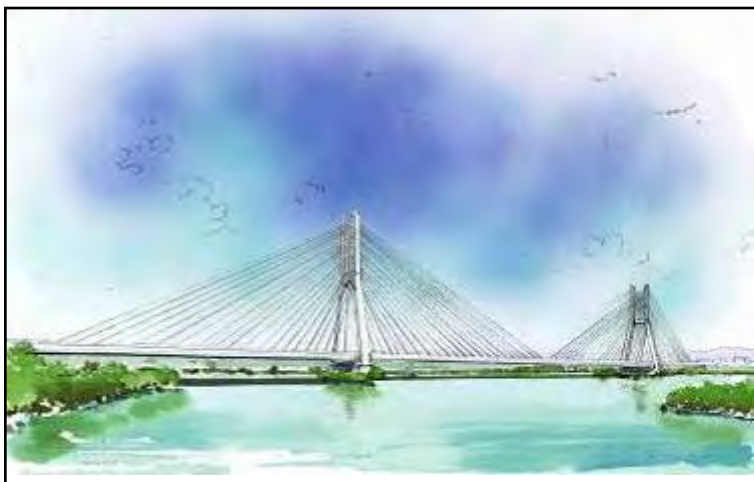
第3案：ケーブル2面張りでH型塔形状
