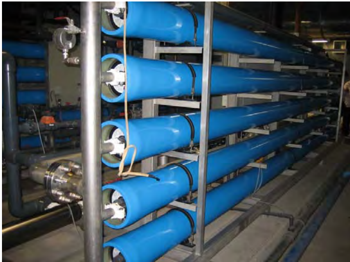
写真-2 マクタン島東海岸のリゾート ホテルの海水淡水化用 RO 膜 (能力 1,000m 3 /日)
