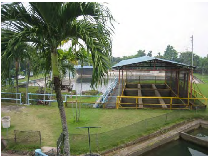
写真-3 MCWD 唯一の Tisa 浄水場。屋 根付きの施設は、休止してい る急速ろ過池で、その奥に緩 速ろ過池が見える。
