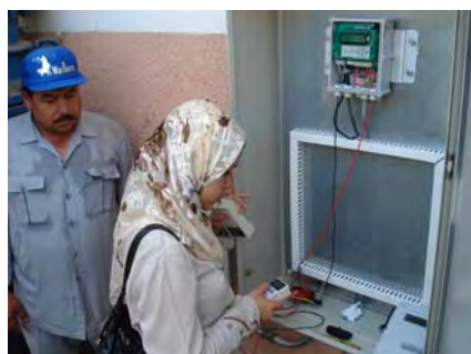
図 4.2-4 アバッサ浄水場の流量計設置状況
