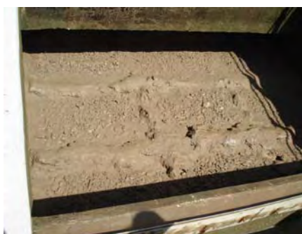
図 4.2-11 洗浄前のろ材の状況
