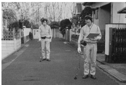
図 4.1-11 漏水探知器による漏水探知作業の様子
