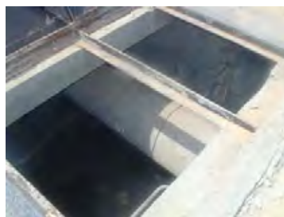
図 4.2-4 アバッサ浄水場の流量計設置状況
