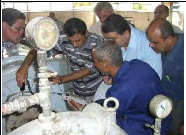
カウンターパートが アバッサ浄水場でモーター振動の整備前と整備後を記録している状況。
