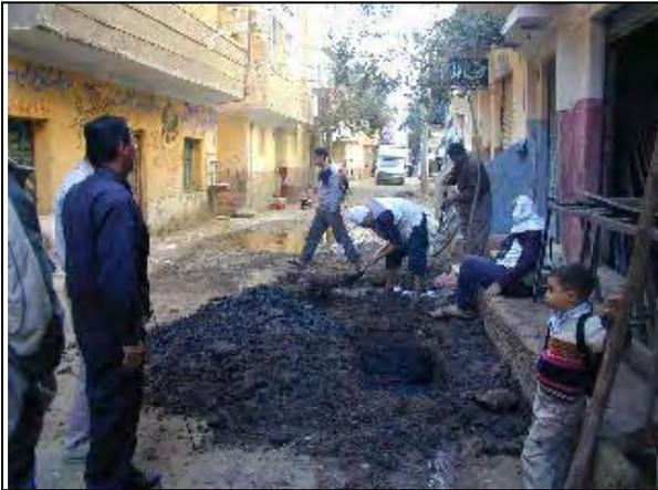
ヒビヤ郡でカウンターパートチームが漏水発見箇所を掘削している状況。
