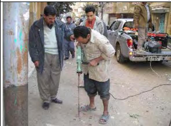
カウンターパートがヒヒヤ郡で漏水箇所をハンマードリルで削孔している状況。(アクション U11)
