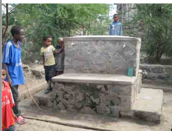
写真-3 (撮影;基本設計調査) : ティグライ州の標準的な公共水栓
