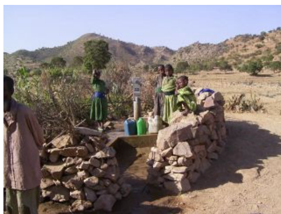
写真-9 (撮影;基本設計調査) : ティグライ州では、アフリディアのハンドポンプを標準ハンドポンプとしている。
