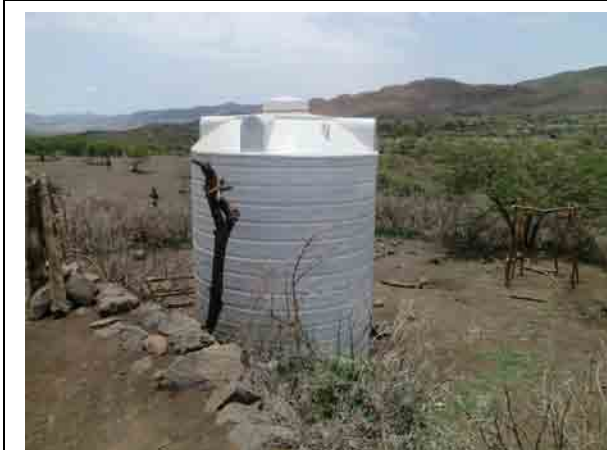
写真-15（撮影;事業化調査）：ラヤ・アゼボ郡ハデアルガ集落に設置された、ポリエチレンタンク（ROTO タンク）。早魃被害対策の緊急給水用として設置されている。
