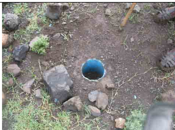
写真-14（撮影;事業化調査）：アラマタ郡ウラ集落で基本設計調査時に掘削した試掘井戸。井戸ケーシングが壊され、埋められている。
