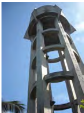
東部地区に建設された 250m 3 の容量を持った高架 タンク、これも流入および流出管は一本で兼用
