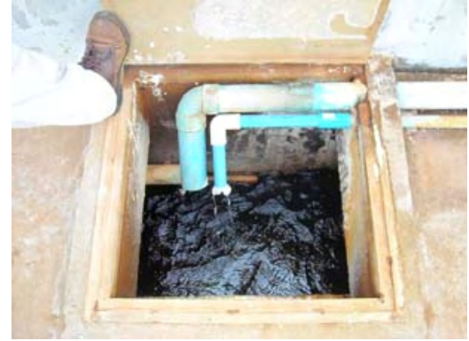
配水池上床版開孔部、 ここから塩素および石灰が注入される (石灰は現在注入されていない)
