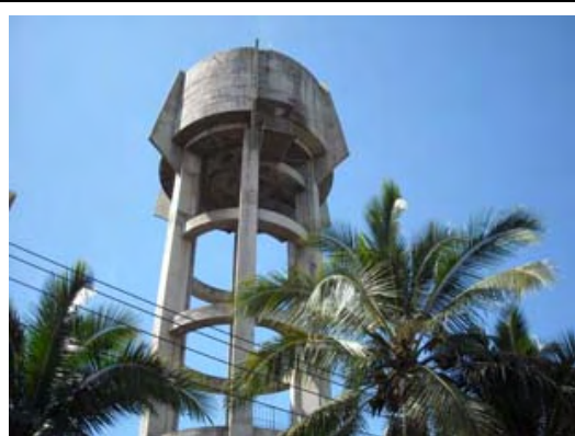
西部地区にある 500m 3 の容量をもった 高架タンク、流入および流出管は一本で兼用、 建設後水道水が貯留したことはない
