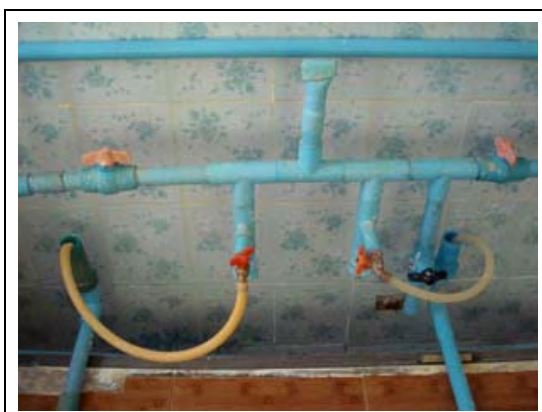
ADB が設置した薬品注入装置は 故障したため現在はマニュアルで注入
