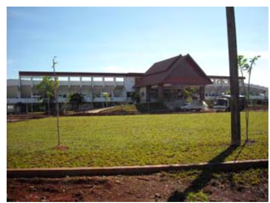
2009 年 SEA スポーツ競技会 開催のために建設中の競技場
