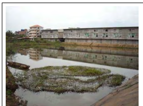
中央マーケット、周辺民家からの生活排水、 汚水を集めて処理する安定化池 (排水路からは未処理のまま直接放流)
