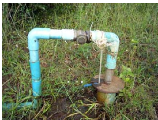
チャンパサック大学に建設された井戸 （2井掘削したが一本は失敗）
