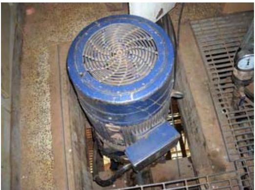
NORAD により、2001 年新設された 取水ポンプ 1 台 (モータ部分)
