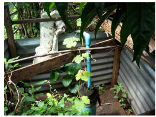
水道の未普及地域では ほとんどの人が地下水を利用している
