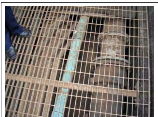
2条の原水導水管φ350
