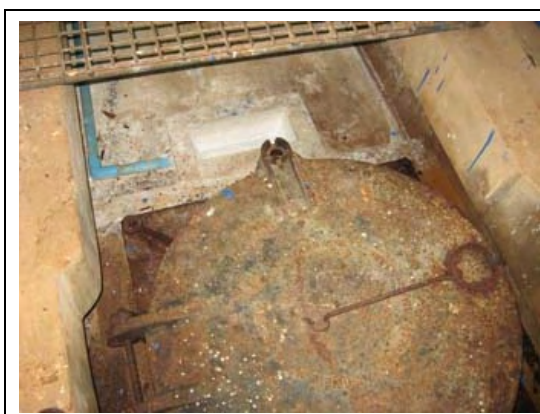
ろ過池流出管のところで塩素注入
