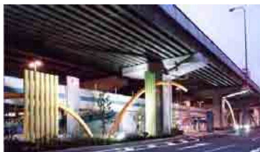
図 3.2.7 高架下の駐車場事例 (江南駅南立体駐車場・大阪)
