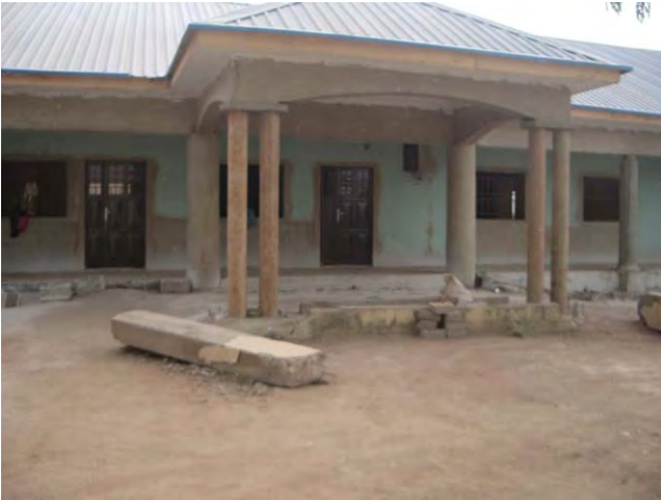
WATSAN プロジェクト事務所（改築中）
