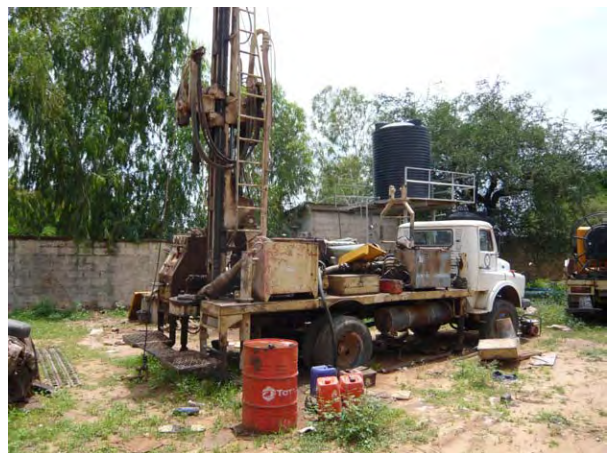
RUWASSA 保有の掘削リグ（1996 年製） UNDP 供与
