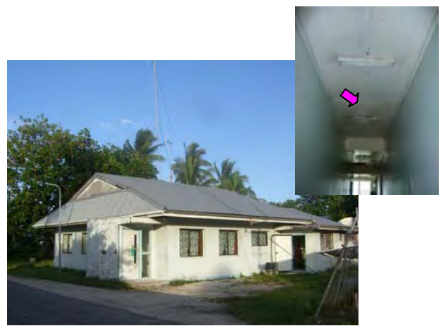
ツバルメディア局（TMD）既設ラジオ放送局舎
