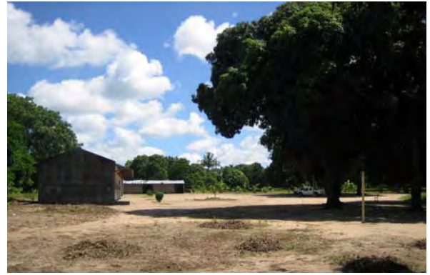
■協力対象校現況:シサノ中学校（ガザ州） 既存校舎と仮設教室。配置計画で考慮すべき樹木がある。
