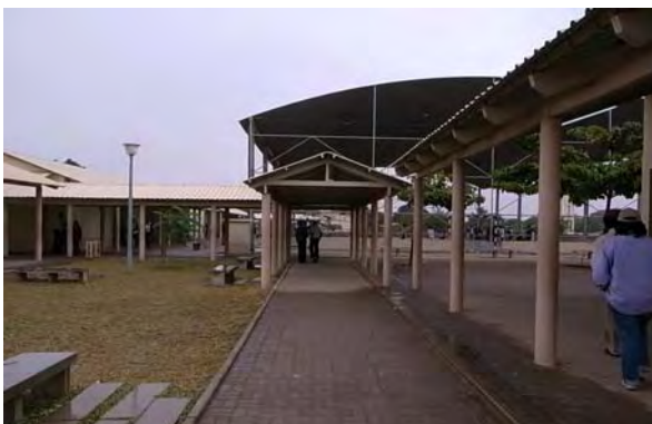
□類似施設:Quisse Mavota 中学校（マプト市） 各施設が渡り廊下で結ばれており、良好な教育環境が整備されている。これ以降の施設整備の標準となっている。（世銀 2004 年）
