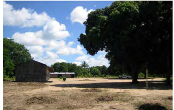
■協力対象校現況:シサノ中学校（ガザ州） 既存校舎と仮設教室。配置計画上考慮すべき樹木がある。
