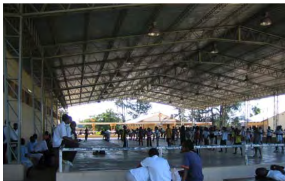
□類似施設:Matola 中学校 (マプト州マトラ市) 屋根付運動場。(2008 年世銀支援 改修)
