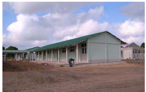
□類似施設:Macia 中学校建設現場（ガザ州） FASE 資金による中学校施設。実施中の他の施設も全て共通の標準設計仕様で整備が進められている。
