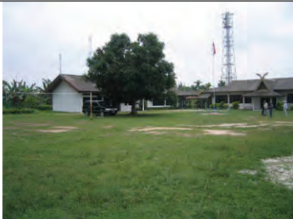
写真 3-1: ドマイ沿岸無線局の状況 (1) (市街地外れに立地しており、電力などの基本インフラは整備されているが、電力事情は良くない。)
