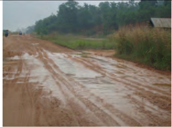
写真 4-4： ドマイ～シリンチン間道路 （ドマイからシリンチンまでの間の道路には、未舗装道路も多い。）
