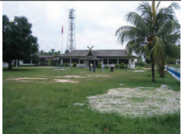
写真 3-2: ドマイ沿岸無線局の状況 (2) (写真右側が、VTS サブセンター建設予定地)
