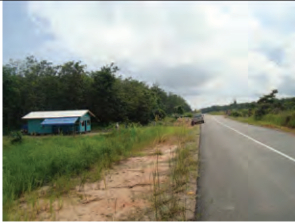
写真 4-3： シリンチン （中継局候補地前面の道路の状況。舗装されている部分の道路事情は良い。）
