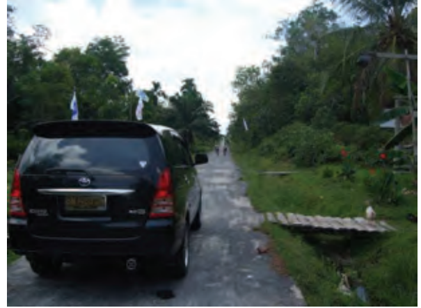
写真 5-4： シンパン・アヤム （サイト前のアクセス道路の状況。コンクリート舗装された道路に面している。道路幅は約 3.5m。）
