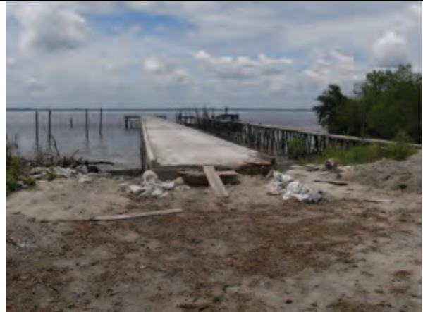
写真 2-3 タンジュン・サイール、サイト近傍の棧橋の状況 (ドマイからは海上アクセスとなるが、サイト近傍にコンクリート棧橋がある。)
