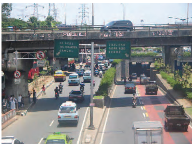
Cawang 立体交差 (アンダーパス)
