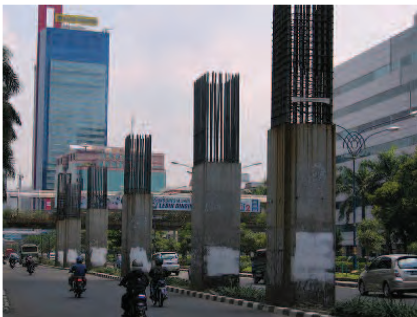
建設がストップしてモニュメント化したモノレールの橋脚
