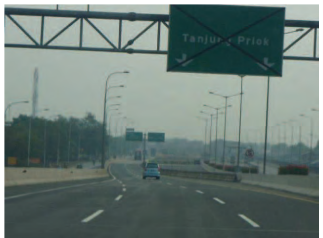
JORR 東区間 Tg. Priok アクセス道路 (未供用) 起点付近
