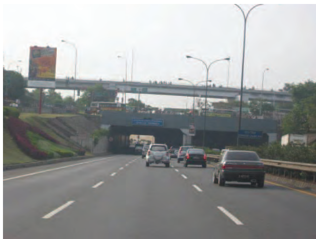
Pasar Rebo - Gedong 立体交差 (フライオーバー)
