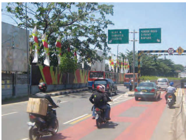
Kebayoran Lama (Pasar) 立体交差 (アンダーパス)
